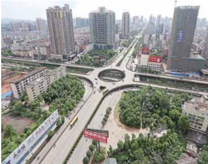
航拍解放大道立交桥
