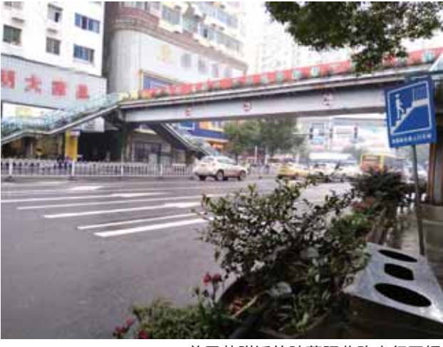
曾子巷附近的跨蒸阳北路人行天桥
