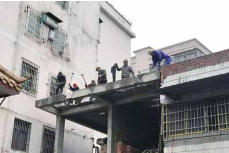
对违法建筑进行拆除
