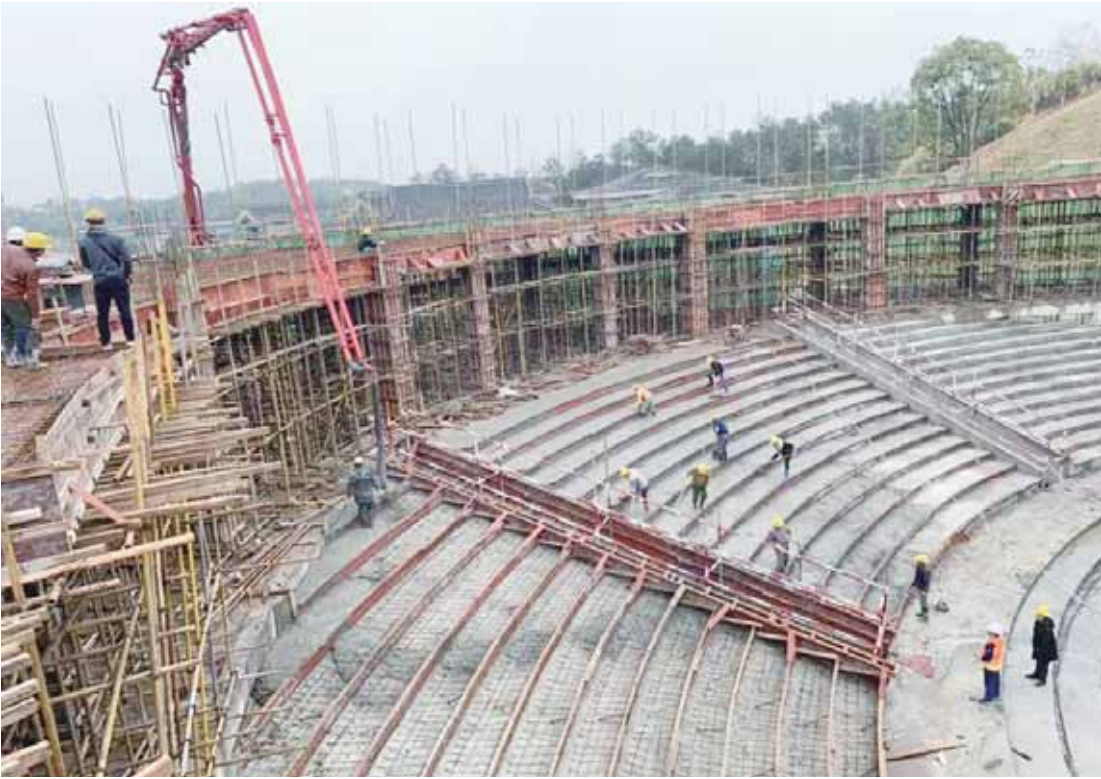
入冬以来，持续低温天气让人们感受到了寒冬的威力，而在南岳区的重点项目建设现场，工人们正战严寒，抢工期、保进度，力争按时完成施工任务。图为天子山火文化园项目火热施工现场。
