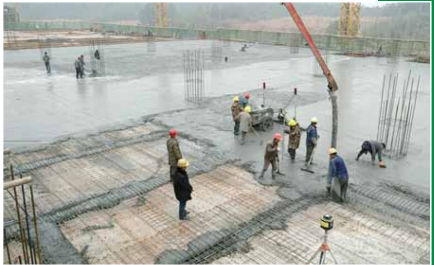
项目建设积极应用新技术。图为楼面激光找平 (资料图片)
