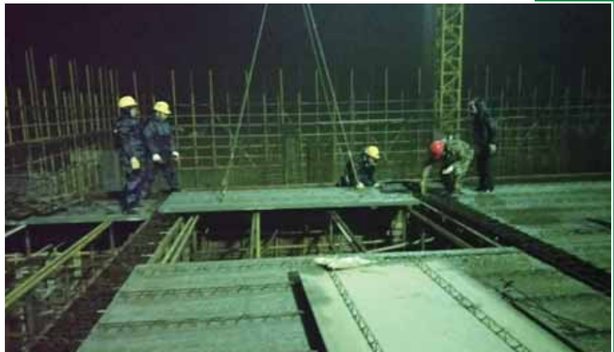
为赶进度,夜间进行吊装等不扰民的施工作业 (资料图片)
