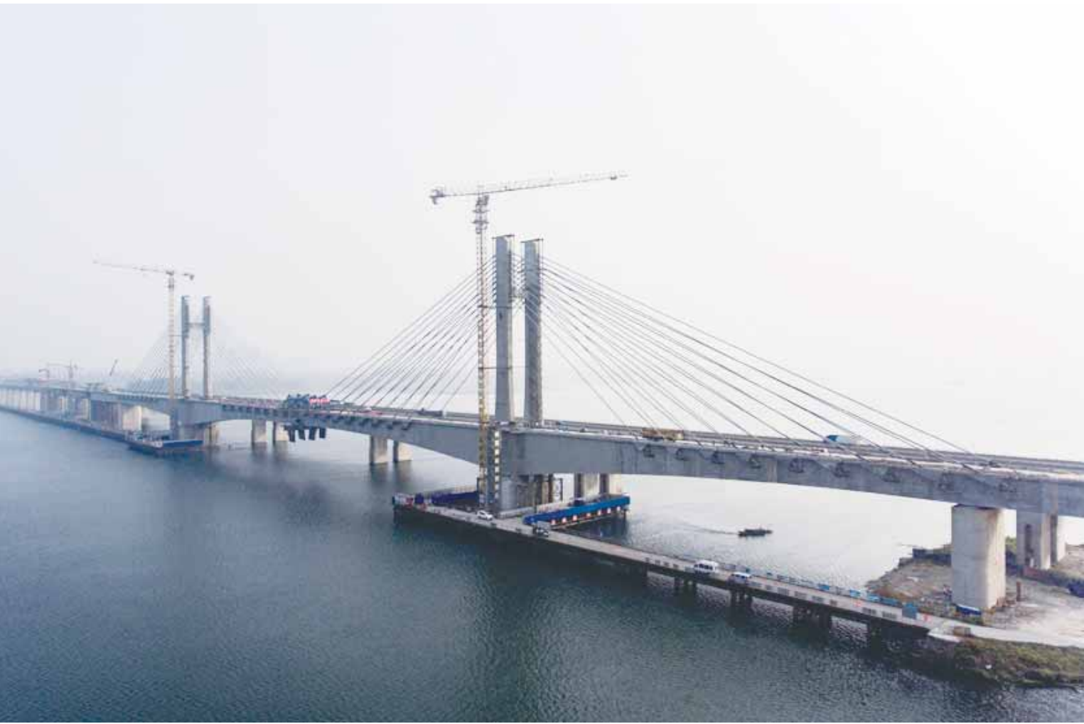
位于湖北省襄阳市境内的蒙华铁路汉江特大桥（10月18日无人机拍摄）。10月18日，蒙华铁路重点控制性工程汉江特大桥主桥顺利合龙。蒙华铁路北起内蒙古鄂尔多斯，终至江西吉安，是我国在建的最长重载铁路。 ■新华社发
