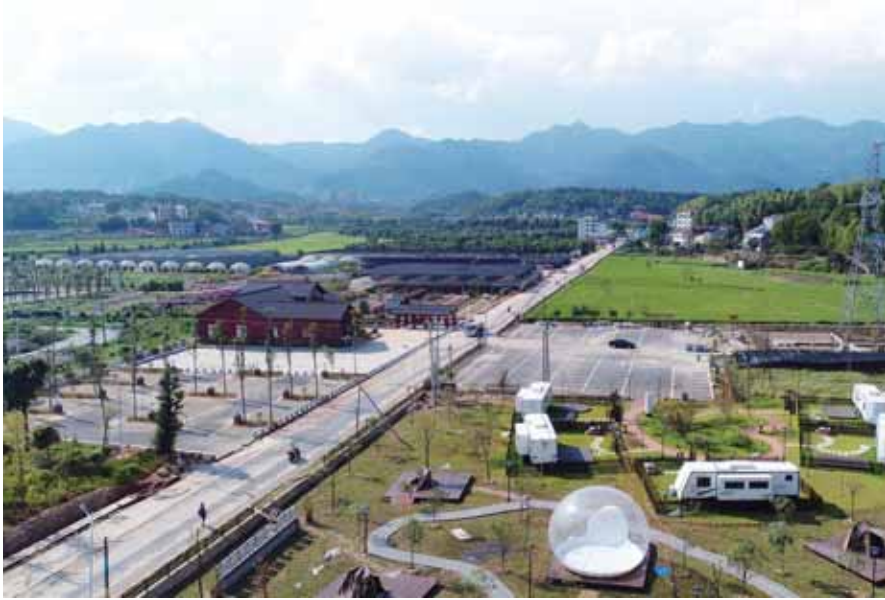
建设中的红星村航拍图
