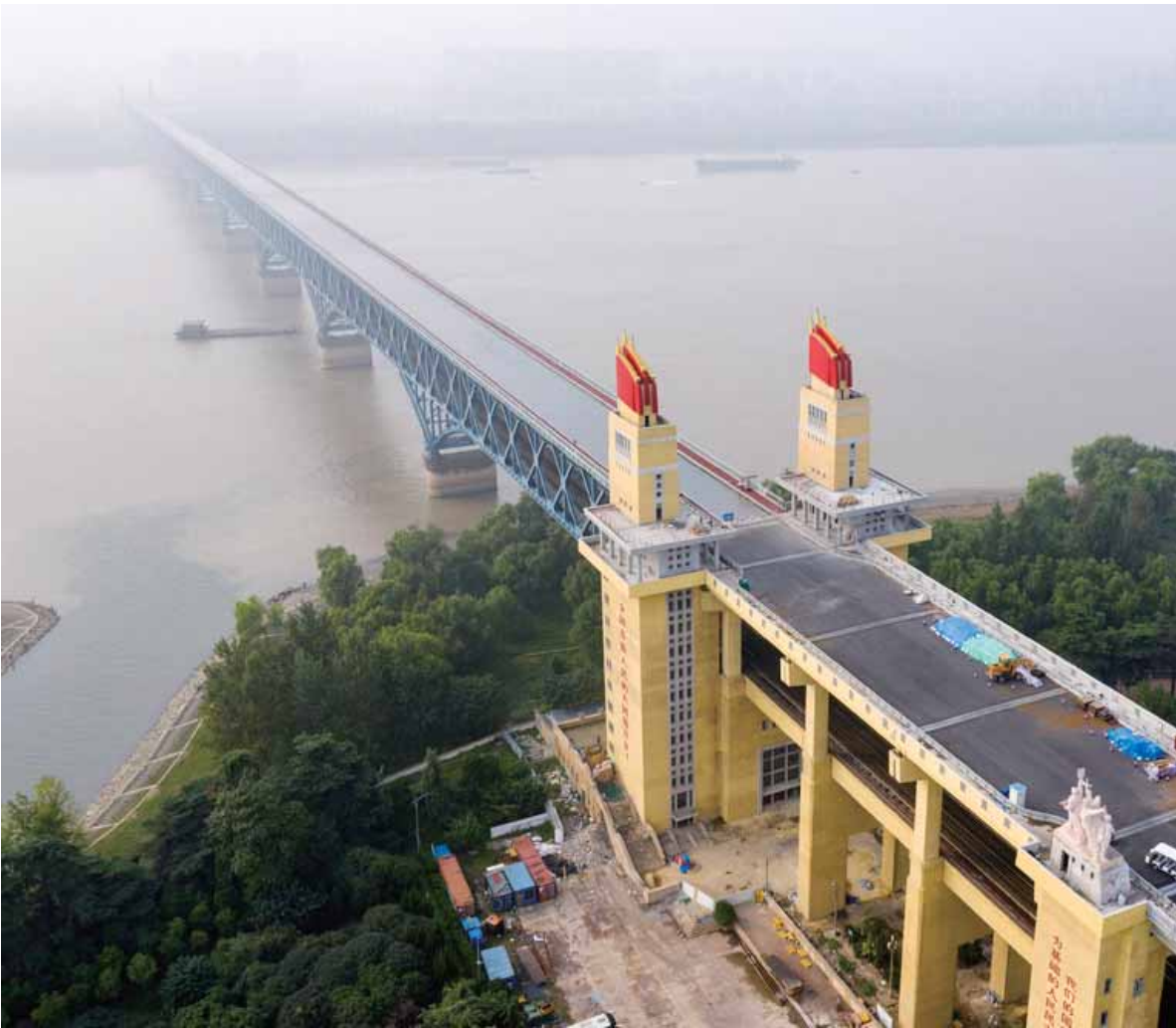
这是封闭维修中的南京长江大桥（9月18日无人机拍摄）。日前，正在进行维修改造工程的南京长江大桥公路桥桥面开始摊铺沥青，桥头堡及雕塑等处的围挡已拆除。南京长江大桥建成于1968年，公路桥于2016年10月28日开始封闭维修，预计2018年年底前完成维修改造，恢复通车。
