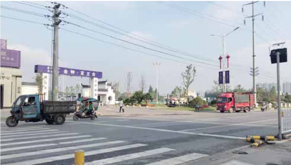
蒸湘南路一排隔离桩遭破坏 ■周连武 摄
