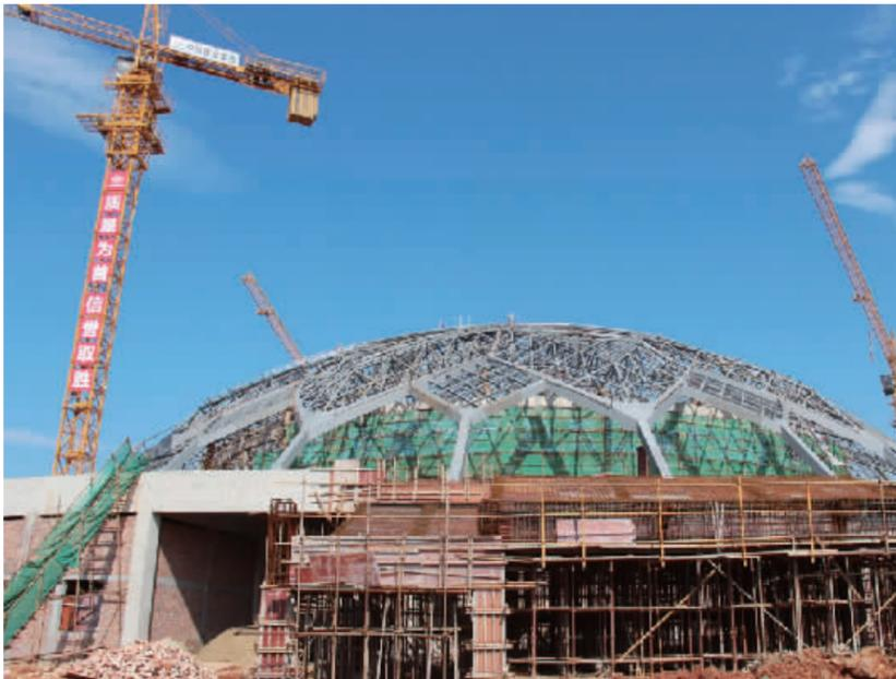
衡山体育馆是省十三运会比赛场馆之一,属乙级小型体育馆项目,占地面积67亩。该体育馆外观造型设计为一朵盛开的“莲花”,其建筑结构为旋柱灌注柱+框架+管桁架屋盖,建筑高度为29.8米,建筑面积1.9万平方米。该馆包括一个可容纳3000人的标准室内篮球场,以及室外篮球场、羽毛球馆和健身房等附属设施。按照施工计划,该馆将于今年6月底全面建成,7月投入试运行。
