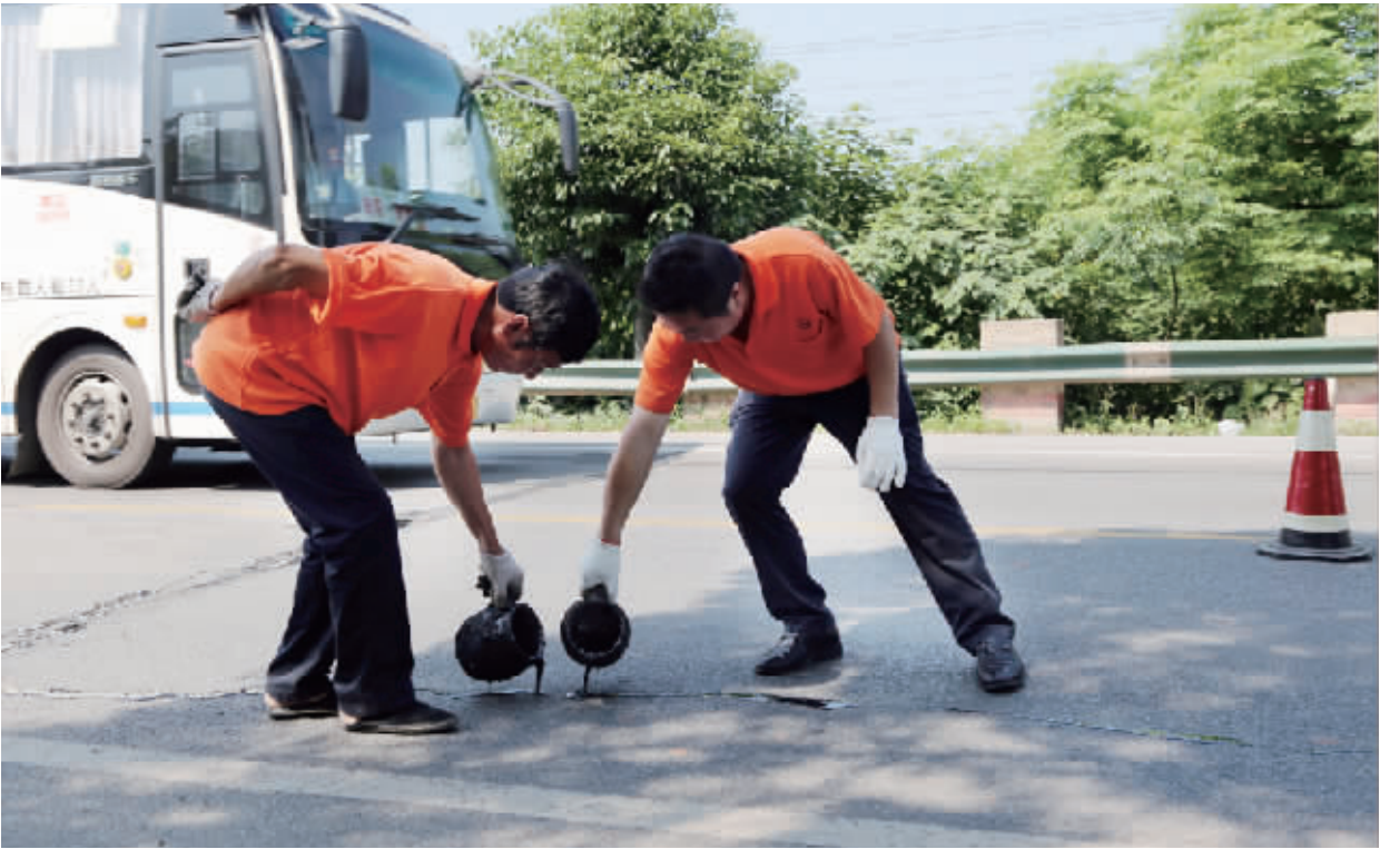
5月17日，珠晖公路分局工作人员在G107线实地进行沥青油膏灌缝现场操作技能比拼。5个小组采用人工油淋，严格按照清缝、灌缝等流程进行。开展这一活动，旨在规范公路灌缝操作流程，提升公路维修质量，强化安全保障意识。
