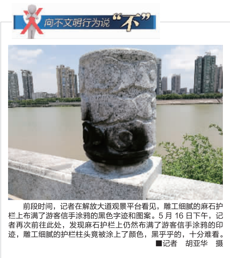
前段时间，记者在解放大道观景平台看见，雕工细腻的麻石护栏上布满了游客信手涂鸦的黑色字迹和图案。5月16日下午，记者再次前往此处，发现麻石护栏上仍然布满了游客信手涂鸦的痕迹，雕工细腻的护栏柱头竟被涂上了颜色，黑乎乎的，十分难看。
