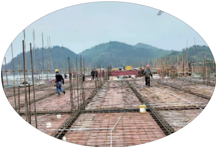
趁着天气晴好，抢抓工期加快进度
