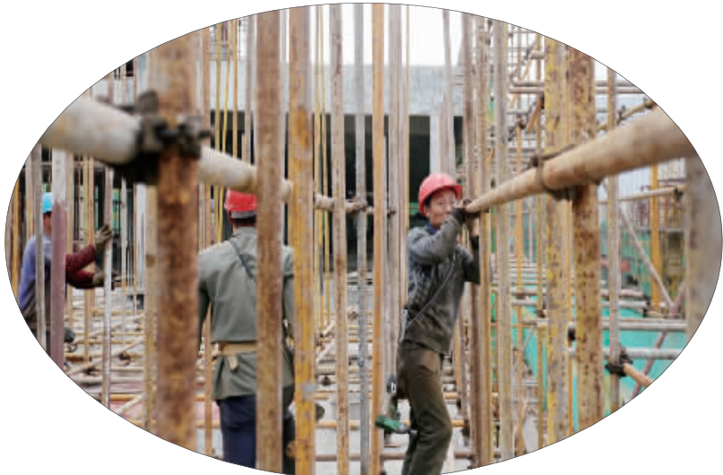
建筑工人精细施工
