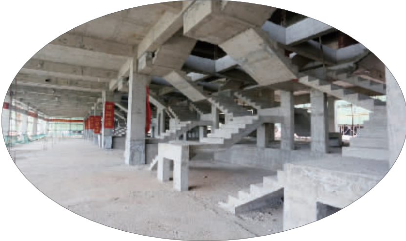
项目主体建筑内部结构
