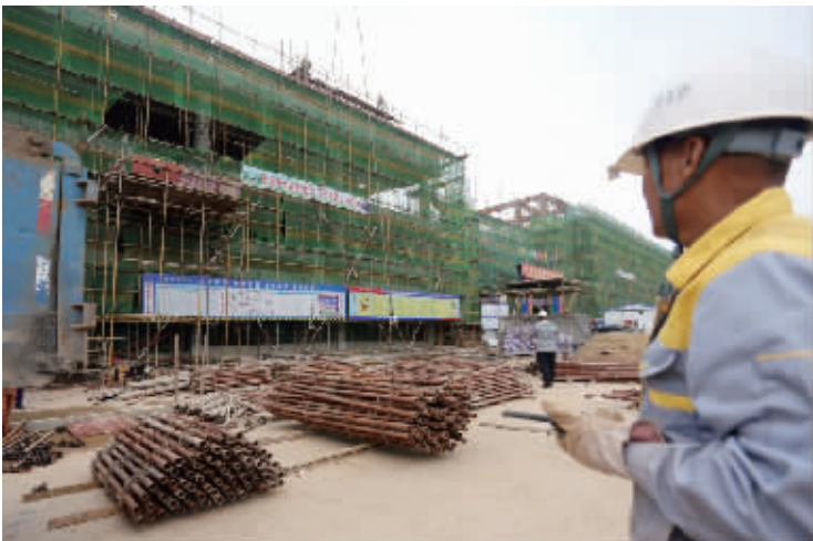
施工现场调度有序
