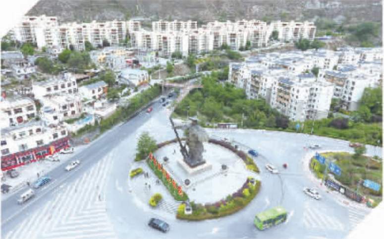
这是在四川省汶川县拍摄的楼房
