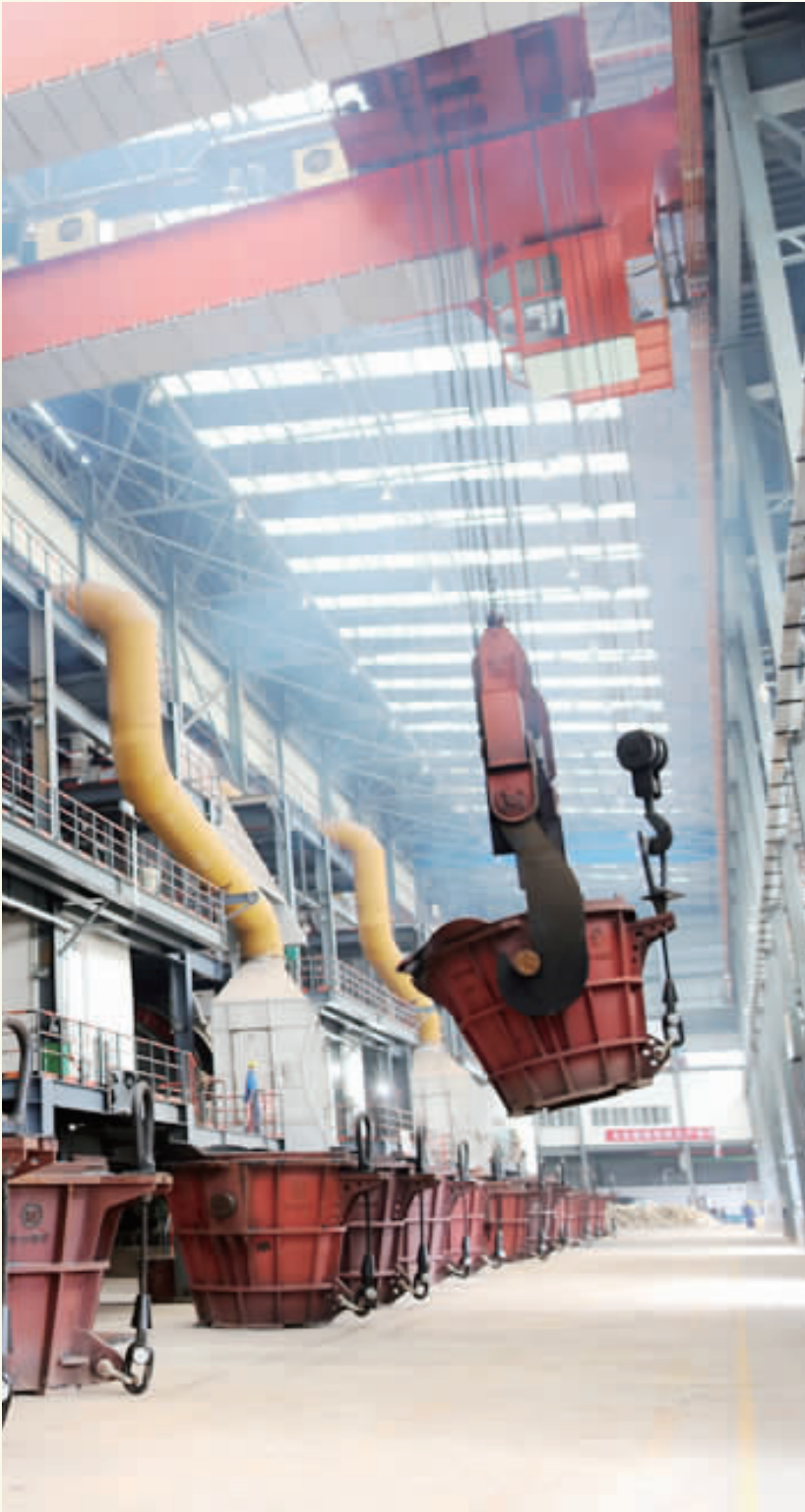
五矿金铜熔炼分厂生产现场，图为正在进行铜流转运至PS转炉
