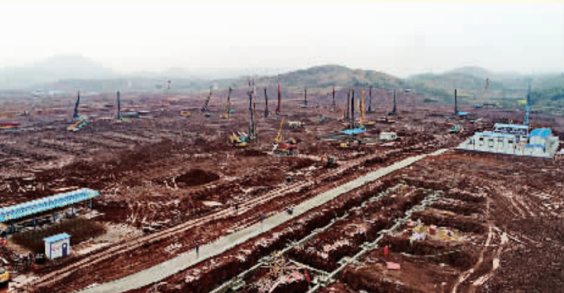
施工现场一派繁忙
