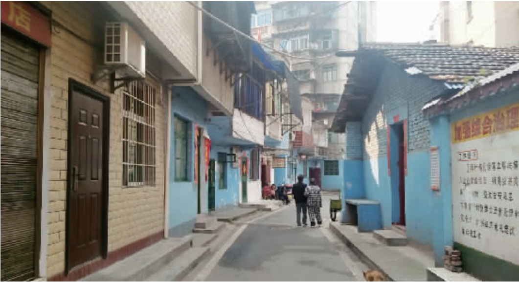
小巷道路铺上了沥青
