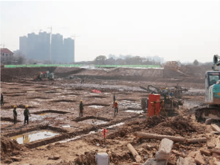
博雅(网球)公园施工现场。
