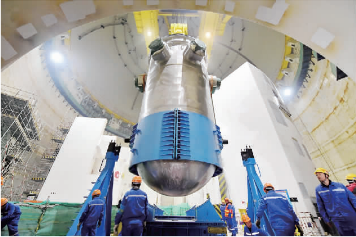
这是福清核电 5 号机组反应堆压力容器抱环拆解现场(1 月 28 日摄)。1 月 28 日 17 时左右,“华龙一号”全球首堆、中核集团福清核电 5 号机组反应堆压力容器顺利吊装入堆。该设备是我国首个具有完全自主知识产权的三代核电工程压力容器,此次顺利吊装将为“华龙一号”机组的后续安装工作开展创造良好条件。 ■新华社发
