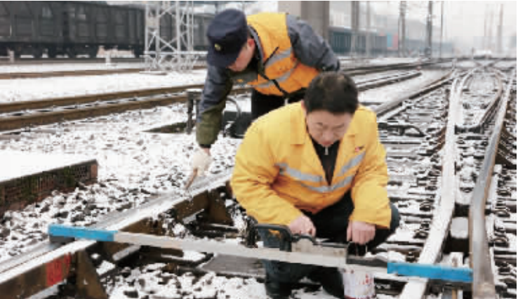
广铁集团衡阳工务段线路车间组织人员进行打冰除雪
