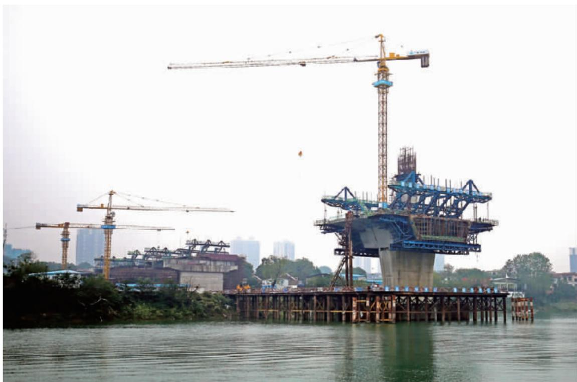
11月21日,东洲湘江大桥水中主墩现已全部完成0号块施工,标志着主桥全部进入挂篮悬臂浇筑阶段,梁体正在加速模块化施工中。大桥起于湘江西岸雁峰区湘江乡东洲村工业园区,止于湘江东岸湘江东路。桥梁设计为三塔四跨矮塔斜拉桥,全长974米,为特大桥。建成之后,一个双向6车道大桥将横跨湘江之上,能够有效分流中心城区的交通流量,缓解交通压力。 ■记者 罗盟 摄
