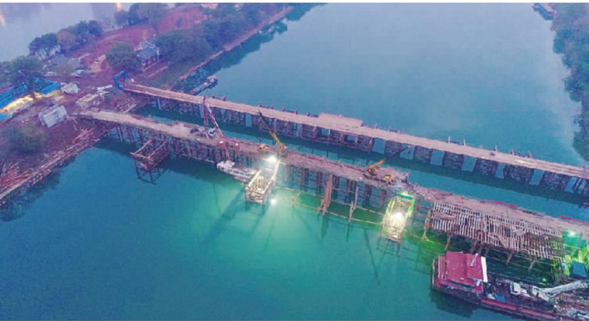
15日下午,记者自东洲岛人行廊桥工程项目部了解到,廊桥最后一个桥墩围堰封底工作已经完成,进入墩身施工阶段。工作人员介绍,届时将实行24小时不间断作业,力争东洲岛建设工程2018年元月开园。图为灯火通明的施工现场。 ■罗盟 摄
