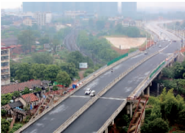
船山东路让衡阳东西向交通更畅通
