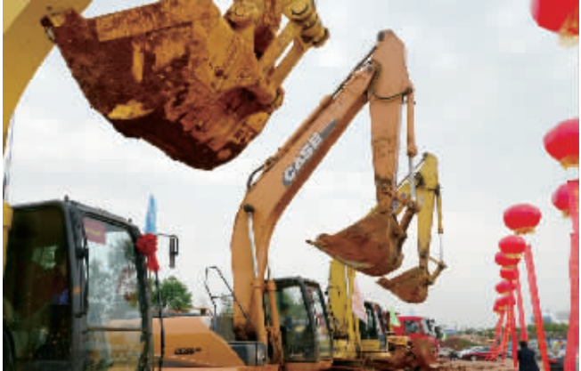
施工设备进入现场
