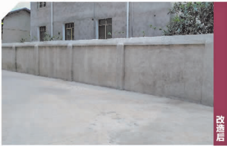
拆除各类违章建筑后，家园变美了
