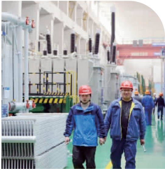
特变电工质检人员正准备抽样检查
