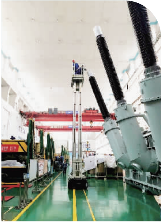
特变电工工人正在安装变压器套管配件
