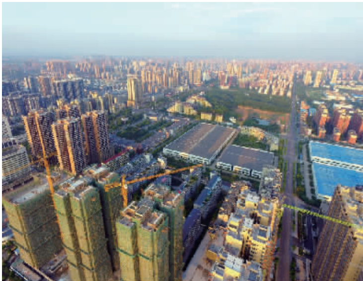
建设中的高新区陆家新区
