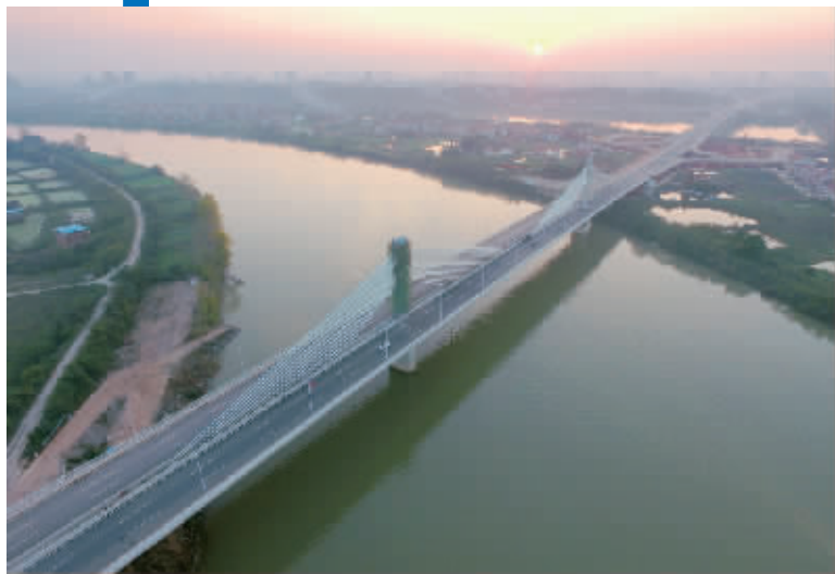
快捷通畅的城市道路让人神清气爽
