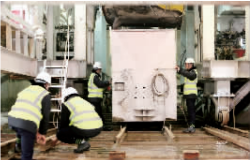
铺设电瓶车导轨。
