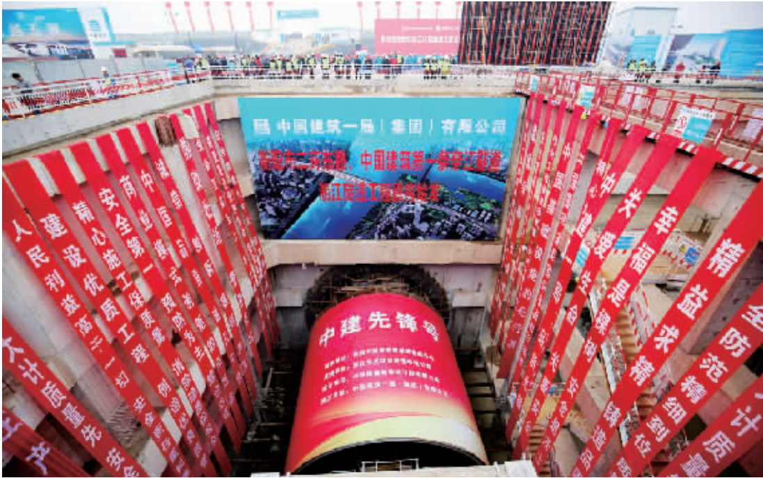
盾构机掘进始发现场。
