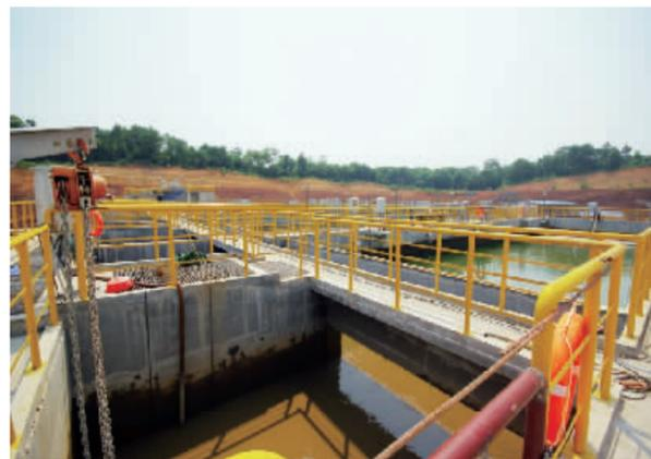
衡东县大浦污水处理工程位于衡东县大浦镇浦泉村12组、炉铺村11组,总用地面积61.4亩。新建日处理1万吨污水处理一座,含重金属污水单独处理系统一座,提升泵站一座,铺设污水收集管网28.7千米。该项目总投资为12000万元,其中污水处理厂5543万元,污水收集管网6457万元。
