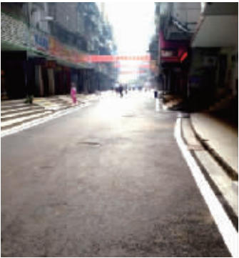
爱民路维修前、后照片
