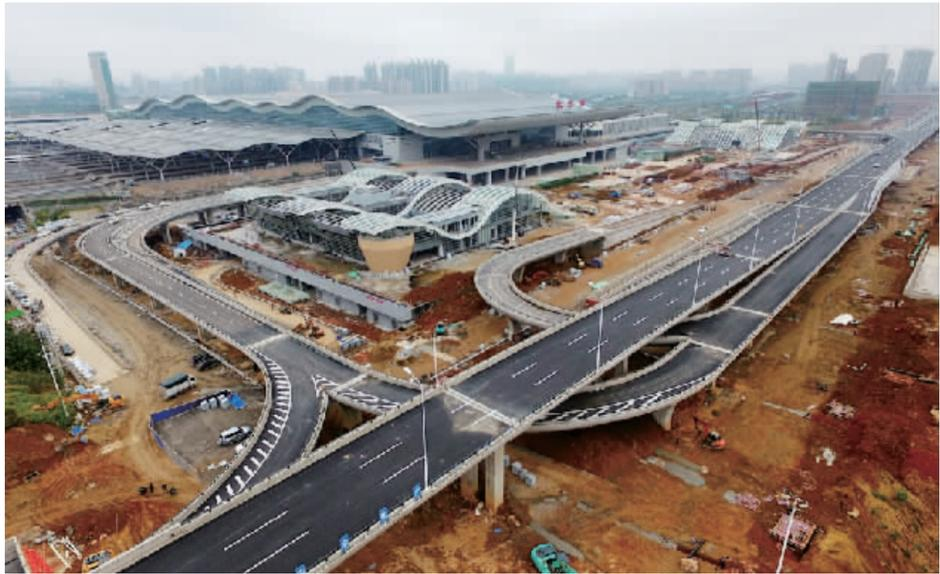
雄姿初现的长沙市红旗路高架桥。近日，湖南长沙首条立体式快速化道路红旗路高架桥主线建成。据介绍，红旗路是长沙城区的一条南北主干道，也是长沙火车站快速疏散通道。该路于2015年8月动工建设，长5.32公里，其中高架桥3.2公里，高架桥上双向6车道，地面双向4车道，设计路幅80米。
