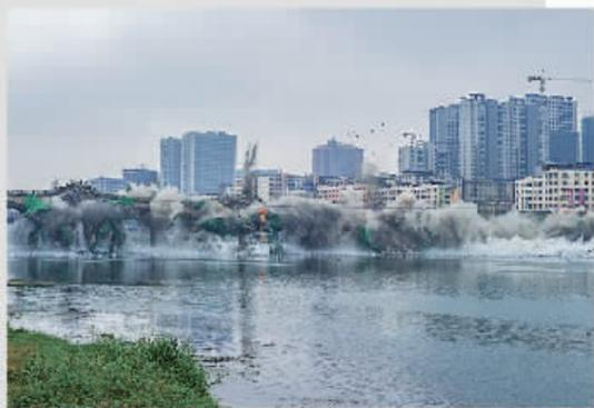
2014年9月24日14点35分,历经40多年风雨的耒阳第一座跨耒水大桥顺利实施爆破拆除。
