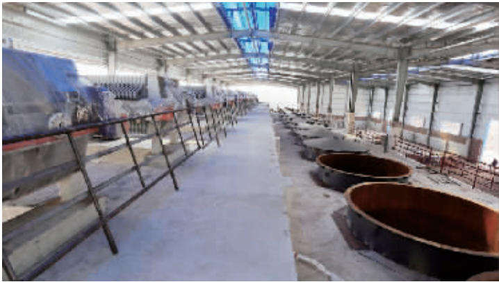
金翼铅业生产车间正在进行设备安装
