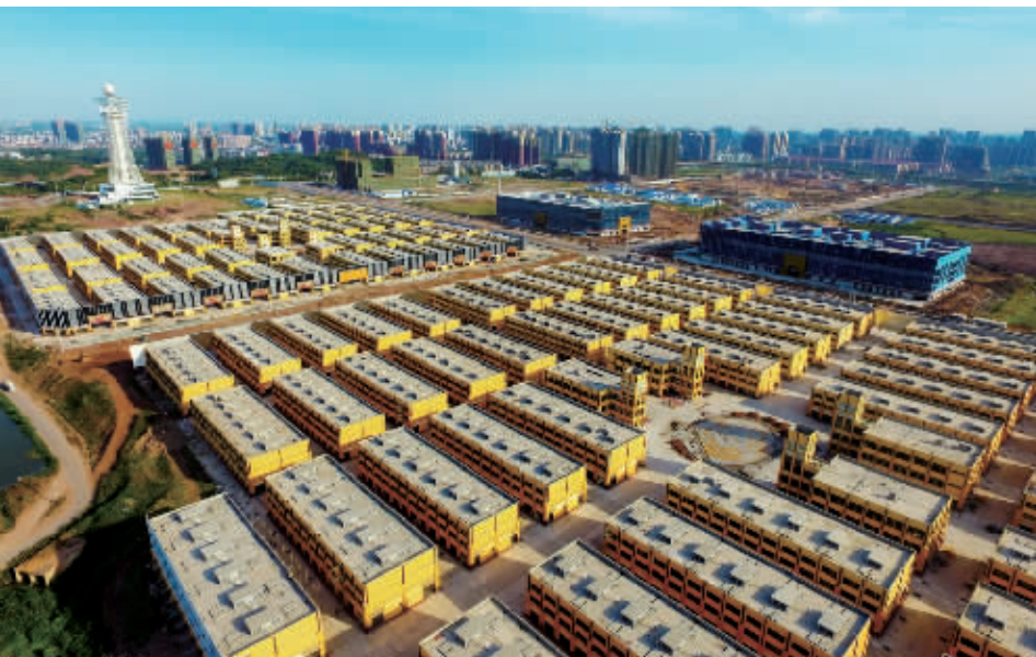
华耀城项目部分主体即将投入使用
