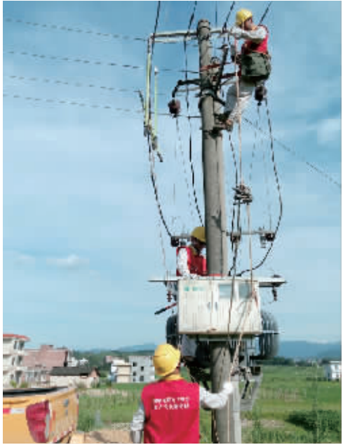
洋泉供电所党员服务队冒着烈日抢修 10 千伏洋杉线 052 杆线路，确保百姓用电。
