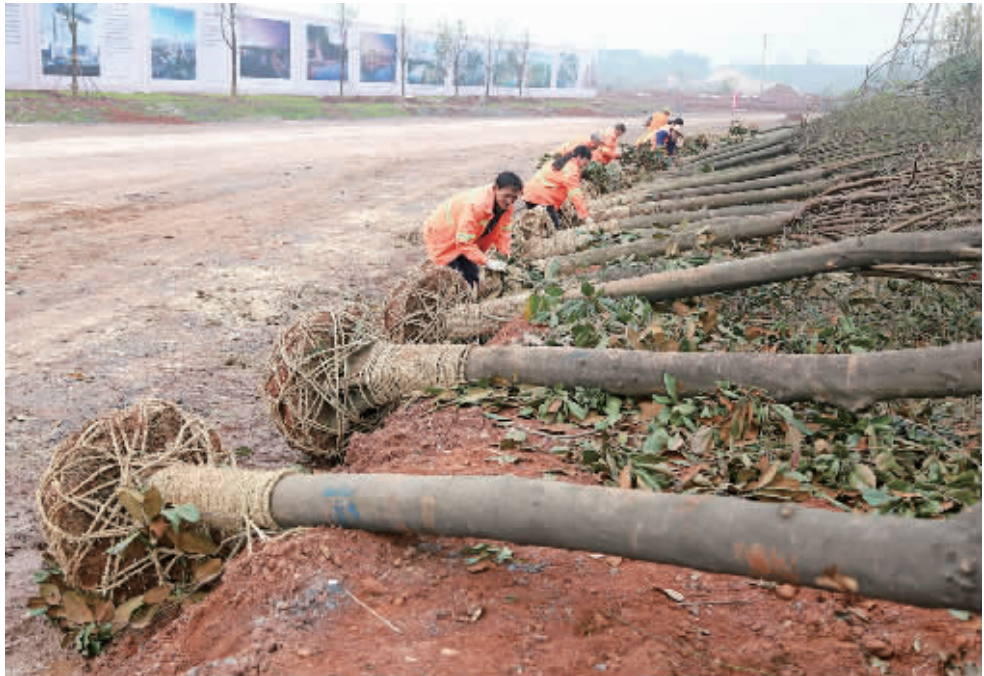
4月6日，高新区临水路及雁鸣溪风光带建设现场，一排排大型乔木正在等待栽种。据悉，目前该风光带土石方已完成90%，绿化完成约80%，树冠长廊及水上栈道已完成桩基础和部分承台。 ■记者 王翟 摄
