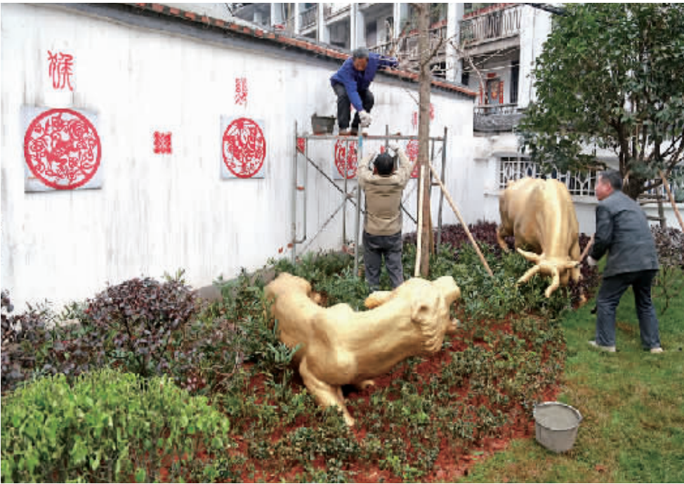
3月30日，几名工人正在“牛虎斗”雕塑前翻新外墙。据悉，牛角巷社区正在进行大改造。目前，该社区已拆除违章建筑55处、拆除防盗网194户、清理垃圾308车、清“牛皮癣”1000余张、清理废旧广告招牌30处。
