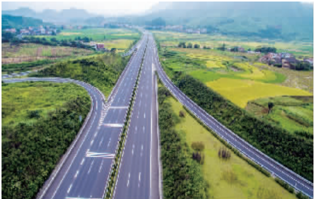
经过常宁庙前的高速公路 ■唐少云 摄
