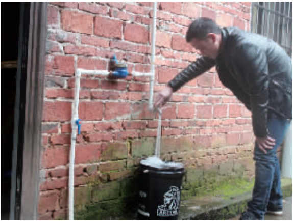
曾洲村的安全饮水工程建设,让百姓喝上“放心水”
