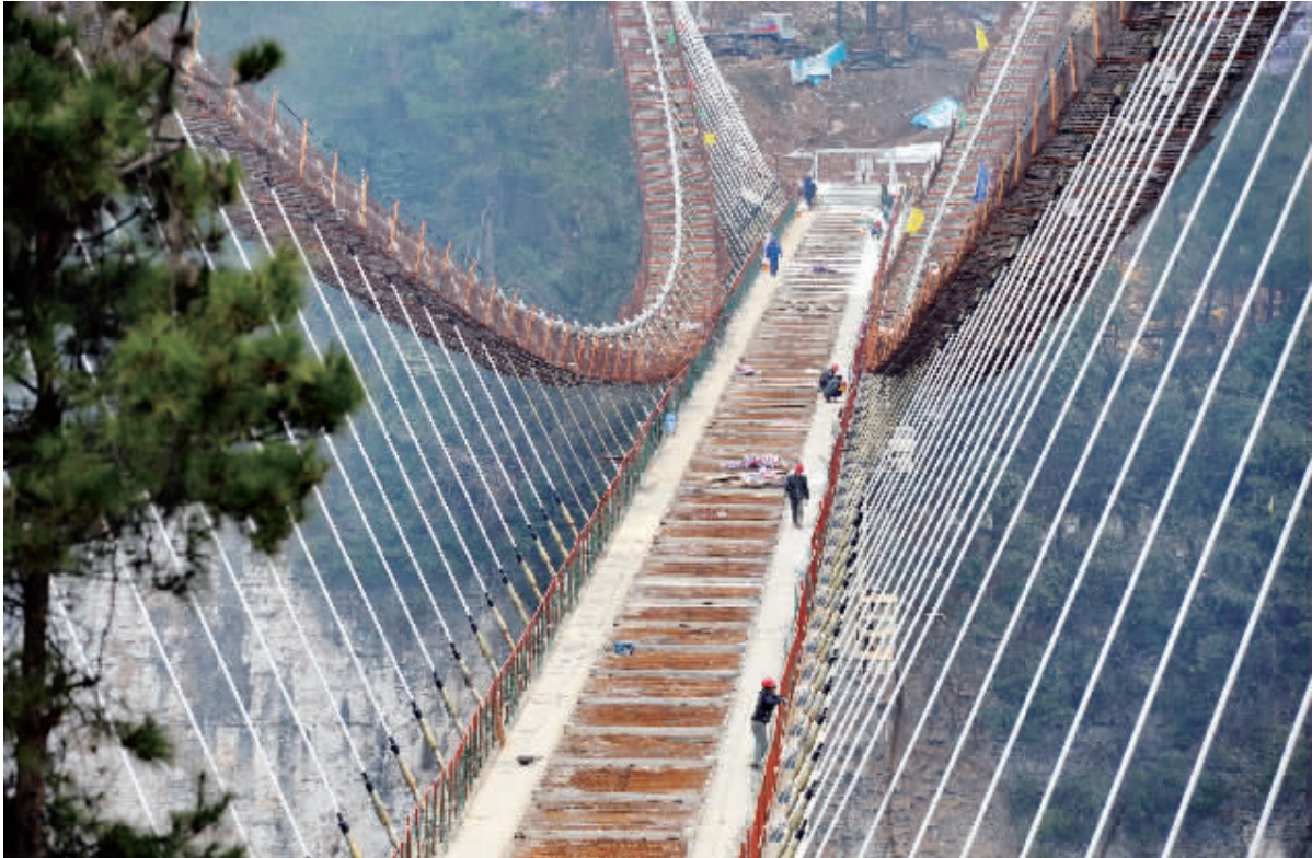
1月27日,备受关注的张家界大峡谷人行玻璃桥正式开始桥面玻璃铺设工程,预计两周内完成全部玻璃铺设。张家界大峡谷玻璃桥桥面由三层玻璃叠加而成,共99块,整个玻璃面的承载量至少达60吨。据悉,张家界大峡谷玻璃桥总长430米、宽6米,桥面距离谷底相对高度约300米。桥面全部采用透明玻璃铺设,最大游客容量为800人。图为俯瞰张家界大峡谷玻璃桥桥面玻璃铺设施工现场。
