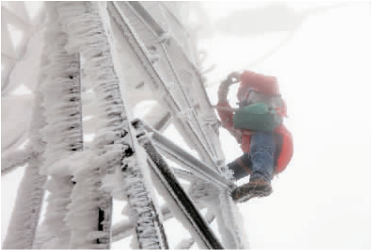
近日,受“霸王级”寒潮的影响,国网衡阳供电公司启动了防冻融冰三级预警。从1月20日开始,国网衡阳供电公司在常宁市天塘山观冰点安排了固定冰情监测哨,运维五班4名观冰巡检人员就在这里24小时坚守值班。每隔规定时间,观冰工作人员都要带着风速仪、温度计、卡尺等测量工具,在风雪中艰难步行1个小时来到观冰点,开展观测工作,并向公司防冻融冰指挥部报告上述数据。图为观冰人攀上铁塔除冰。 ■彭智勇 摄
