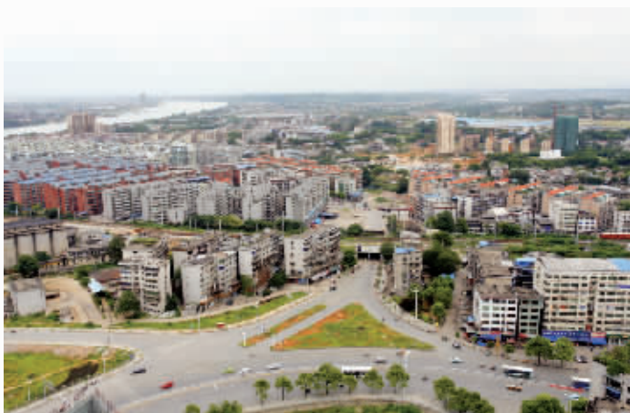
船山东路与东风北路立交拆迁前全貌
