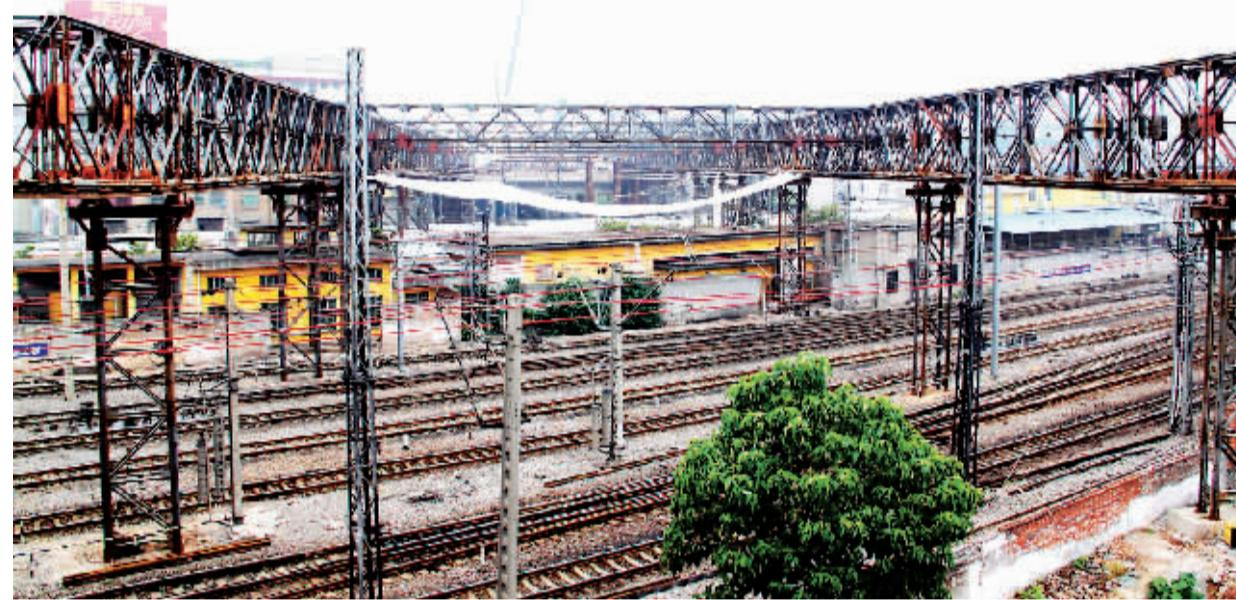
图为系杆拱桥的东、西两个主墩连接后形成的拖拉跑道。
