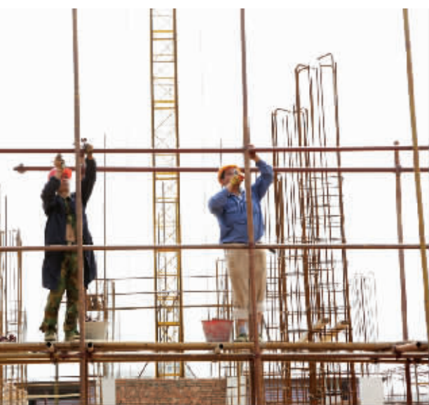
常宁宜水新城建设如火如荼，为了确保建筑质量，施工人员按章操作，严格每一个环节，为工程质量奠定了基础。图为施工人员正在打脚手架。 ■李飞跃 摄
