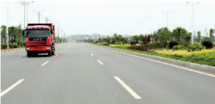
衡阳县西渡镇连接衡邵高速的英秋大道于去年建成通车。该路全长3674米，路幅宽60米。为提升道路形象，该县对此路段进行了绿化亮化。图为绿化后的英秋大道。
