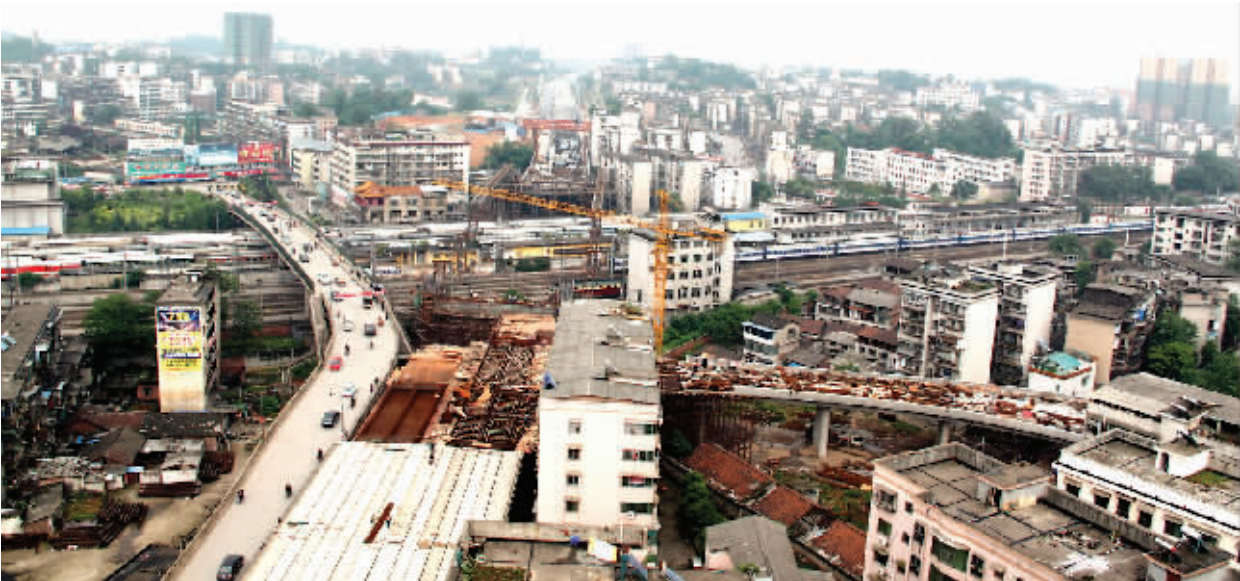
衡州大道跨京广铁路系杆拱桥施工现场远眺。
