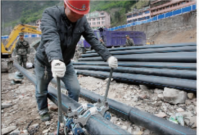
4月23日，水务部门的施工人员在重铺输水管道。
