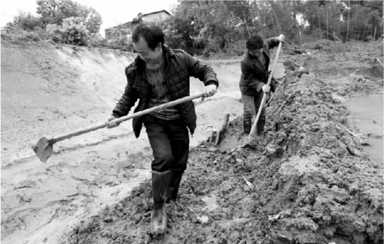
春耕正当时，蓄水赶为先。为了确保农田灌溉的水资源，珠晖区衡州街道积极筹措经费，有计划组织人力，按步骤对辖区内 260 多口鱼塘进行了维修加固，为春耕生产奠定了基础。图为茅坪村群众正在有序地加固塘坝。
