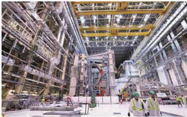
国际热核聚变实验反应堆建设现场。
