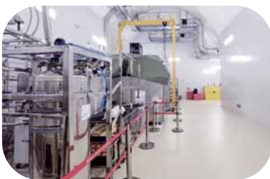
12月7日,中国锦屏地下实验室二期极深地下极低辐射本底前沿物理实验设施土建公用工程完工。
