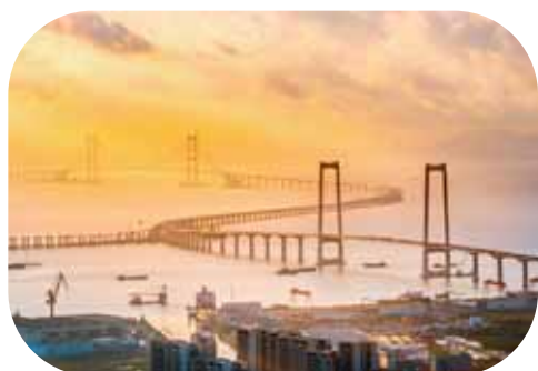
11月28日,国家重大工程深中通道主线贯通。
