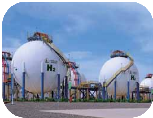
6月30日,我国首个万吨级光伏绿氢示范项目——库车绿氢示范项目顺利产氢。
