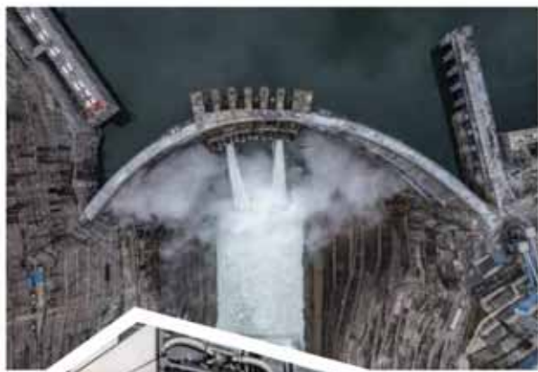
白鹤滩水电站
